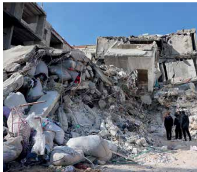
Rund 7.400 Gebäude sind in Syrien ganz oder teilweise zerstört.
