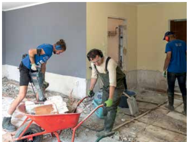
Junge Helfer bei der Entkernung einer beschädigten Wohnung.
