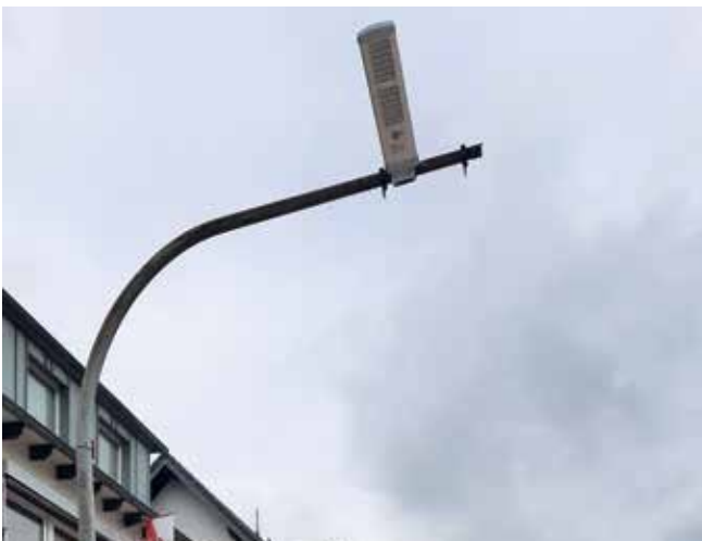
Solarbetriebene Straßenbeleuchtung in Dernau.
